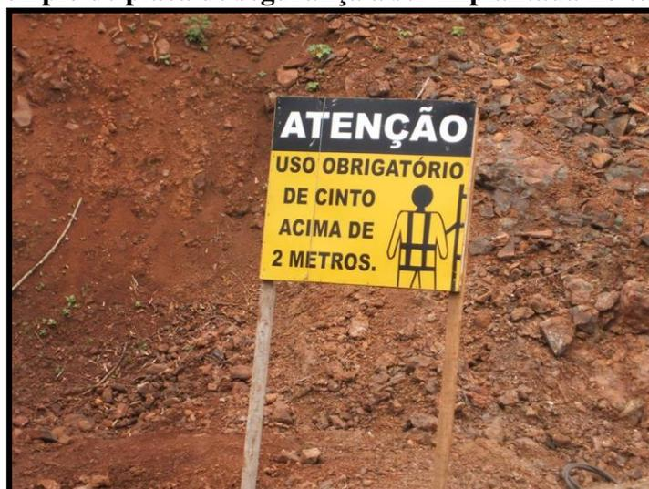
**Figura 13: Exemplo de placa de segurança a ser implantada no canteiro de obras.**
